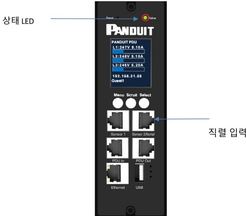
그림 2: 상태 LED 및 포트 내 직렬 포트 식별됨
